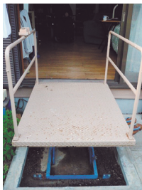
▲②電動段差昇降機
